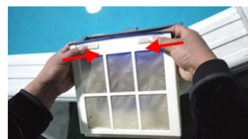
3. Työnnä kesemmälle, jotta suodatinkotelo aukeaa
