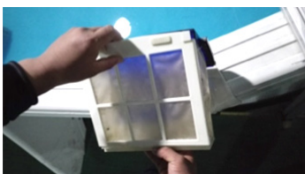
4. Nosta suodatinta noin 2 cm suodatinkotelosta
