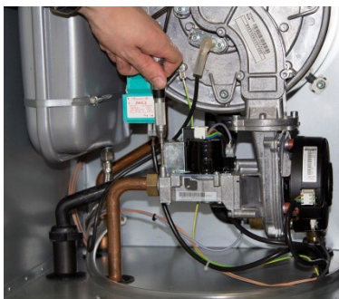
Abb. 4: Öffnen des Messsstutzens
