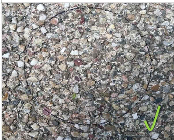
図 5 地面の例（溝なし）
