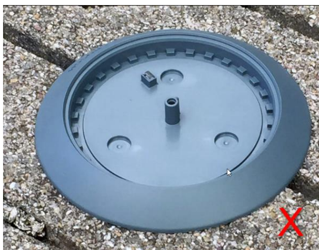
Figura 6 Esempio di pavimento (fessura)
